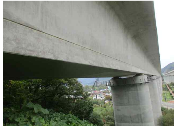
거더 외부 전경
