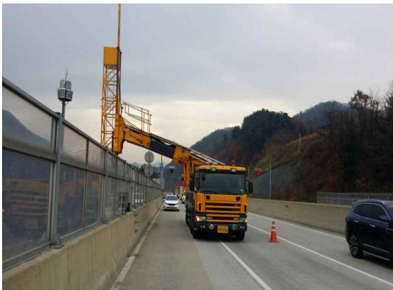
작업차량(굴절차)을 이용한 외관조사①
