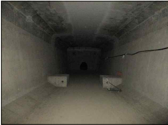
거더 내부 전경
