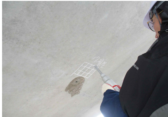
거더외부 압축강도 측정
