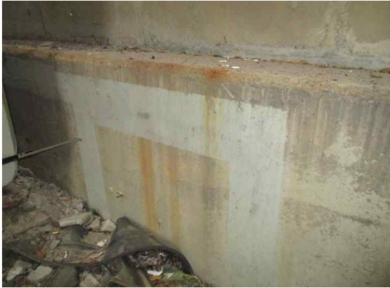
교대 균열보수 현황(A1)
