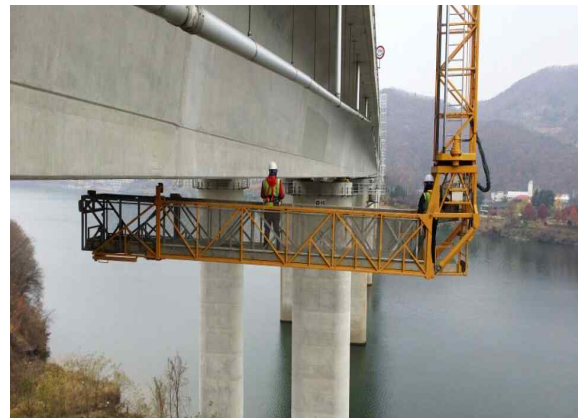
작업차량(굴절차)을 이용한 외관조사②
